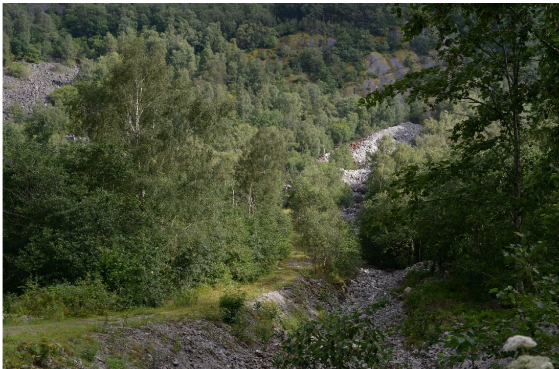
Figur 4-3 Ledevoll som hindrer sideveis spredning av flom- og sørpeskred ved kraftanlegget i Simadalen (Foto: NGI)
