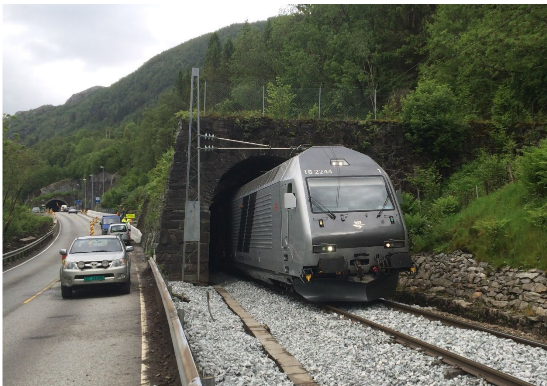
Figur 4-4 Overbygg ved Bogelia, Bergensbanen som beskytter mot blant annet sørpeskred (Foto: BaneNor)
