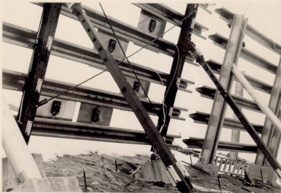
SNÖFORBYGNING SETT NEDENFRA I RETN. NORD - VEST
