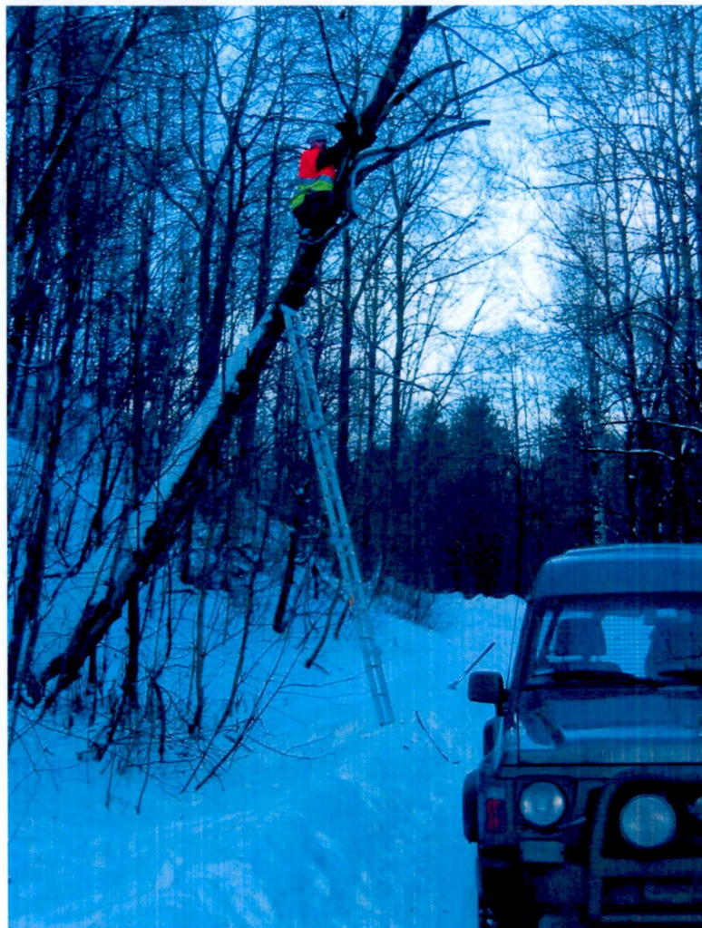
Figur 11: Magnetometrene ble plassert 5 m over vegbanen.
