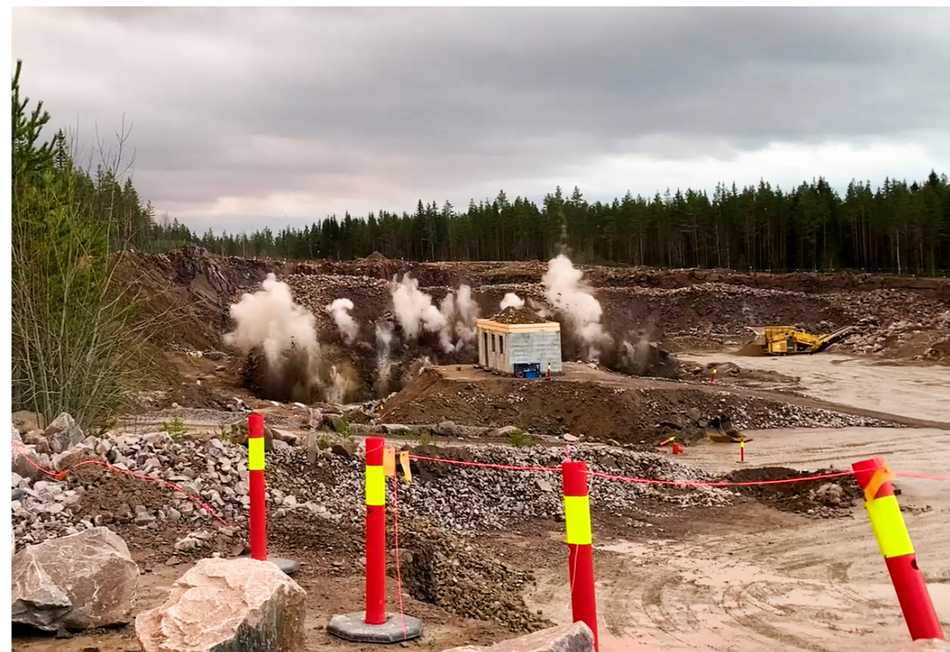
Sprengningsforsøk i Spjulsåsen steinbrudd i 2020. Testbygg i Leca blokker på fylling. Foto: NGI
