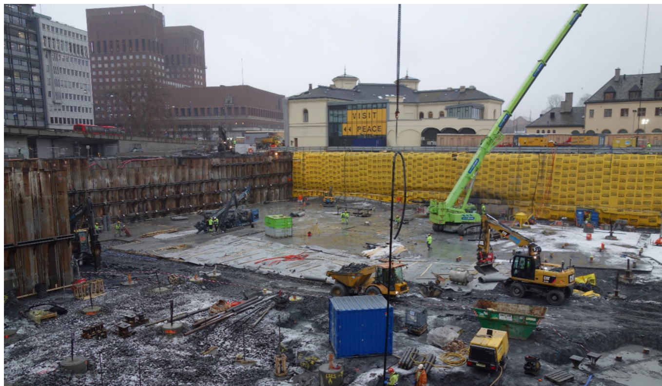
Bygegrop og fundamenteringsarbeider påvirker omgivelsene, avhengig av grunnforhold, byggemetoder og avbøtende tiltak
