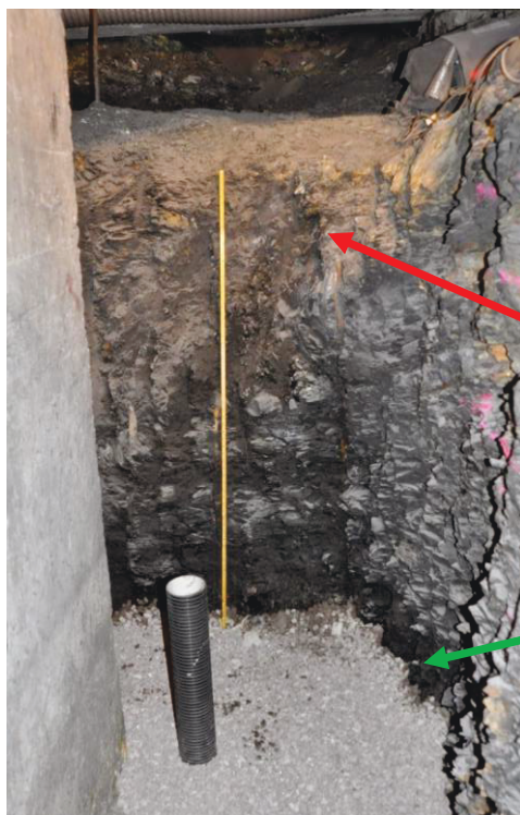
Figur 2.3-1: Grunnvannsspeilet står opp i en spiss i veggen i grøft ved C3-B3. Vannanalyse følger i vedlegg. Dette hjørnet vil naturlig være mer utsatt for forvitring siden vannspeilet står så nær overflaten.
