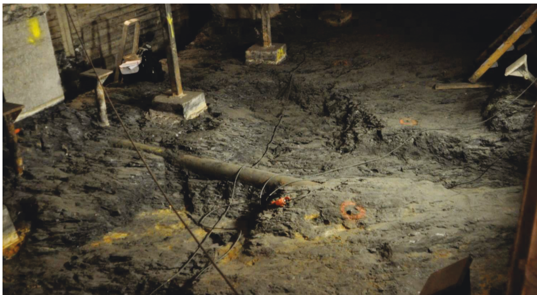
Figur 4.2-3: Utpigget overflate før forsegling. Det er pigget ut ekstra for VA under nytt gulv. Foringsrør for sprinkler er delvis frigjort
