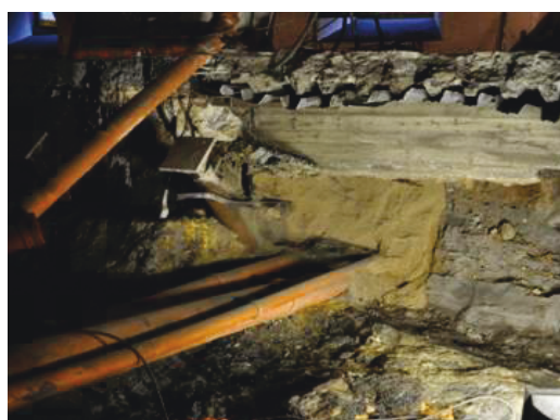
Figur 4.2-5b: Det anbefales å undersøke om fallet i avløp endrer seg som følge av svelling. Drenering anbefales fulgt opp regelmessig.
