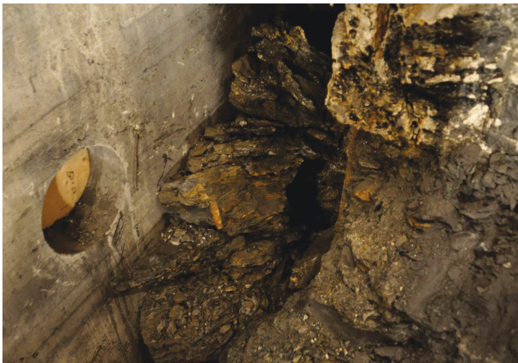
Figur 4.3-2 Utfall i grøft er en kombinasjon av utfall som skyldes sprekkesett og mikrosprekker i alunskiferen (se også figurene 4.2-1, 4.3-1 for variasjon). De grove blokker hviler på mer finkornet forvitret skifer.
