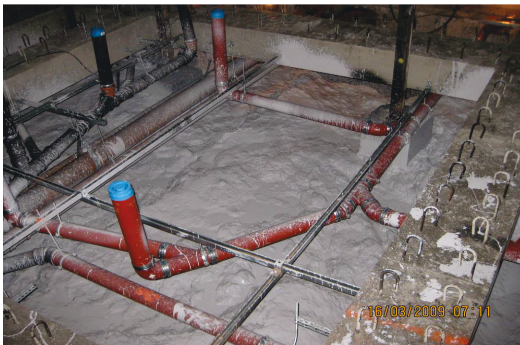
Figur 4.2-4: Areal etter forsegling. Flaten er lett å inspisere, den er tett for vannlekkasjer og tåler strekk om skiferen under utvider seg. Foto: PEAB
