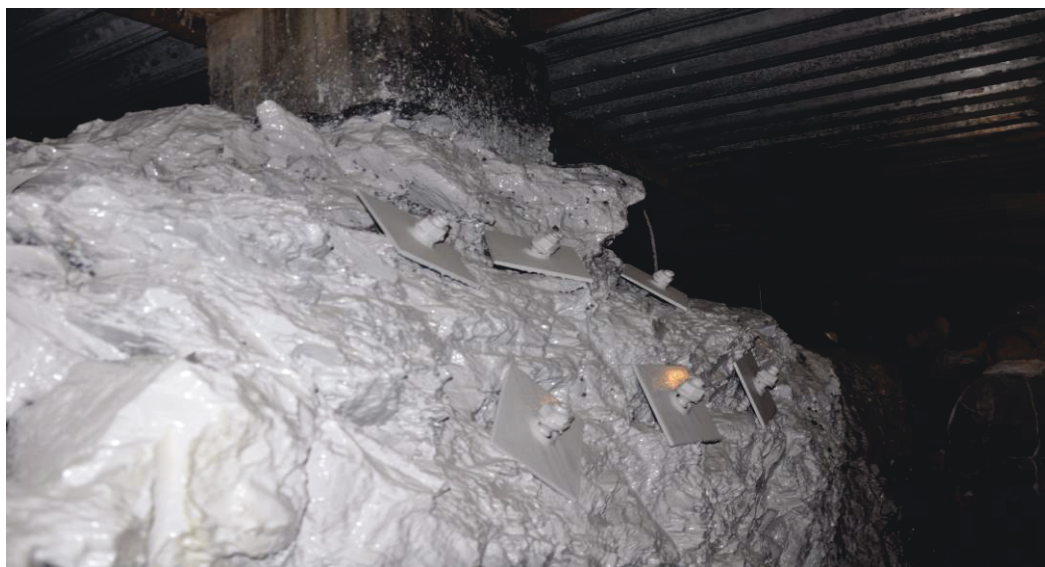
Fig. 4.6-5 Forseglet skifer under fundament. Grå flate er Resflex membranen.
