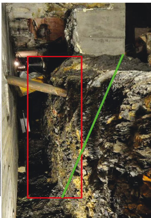
Figur 4.6-1: Grønn linje viser risiko for eventuelt skjærbrudd ved svekking av foten av kilen som følge av forvitring i foten av grøften. Gule felt på den vertikale flaten viser forvitret skifer. Det ble ikke anbefalt å fjerne mer skifer.
