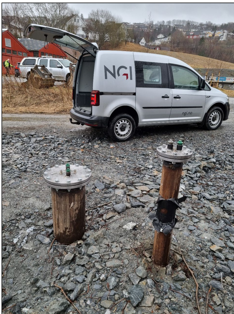
Figur 4-2: BEAR-prosjektets pilotpeler ferdig installert sommeren 2022.
