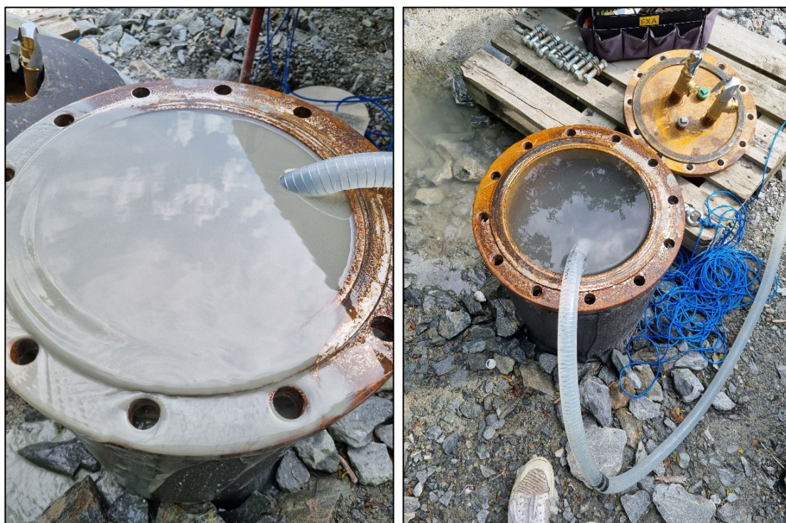
Figur 4-10: Spyling av stor pel sommeren 2022. Ca. 4-5 meter av pelen var fylt opp med leire og silt og hindret tilkobling til TRT-riggen for termisk testing. Gjennom-spyling med vann i 10 timer rensset ut dette, men over tid ble pelen på nytt fylt opp med leire. En lekkasje ble senere oppdaget i en av sveise-skjøtene.
