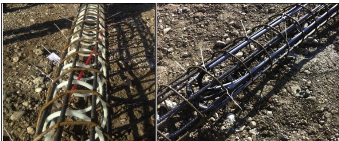
Figur 3-5: Montering av kolektorslanger på forhånd i armeringen er en vanlig metode som er mye brukt til plaststøpte peler. t.v. sees en spiralkollektor (ref. Figur 3-4e), mens t.h. sees en dobbelt U-kollektor (ref. Figur 3-4b) (Zarrella et al., 2013)
