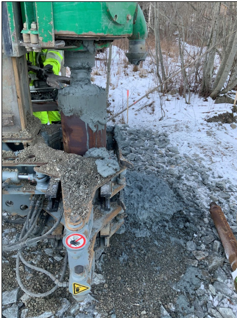
Figur 4-5: Bløt leire fra 2-3 meter og videre før berg påtreffes ved 26 meters dyp. Leiren er relativt seig og renner ikke unna. Brukt mest luft for spyling, men noe vann for å lette på heften til rørveggen. Frost gjorde imidlertid at vannet og leiren fort frøs til is.
