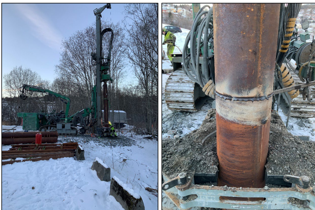
Figur 4-4: Oppstart boring av \varnothing 323 mm stålørpel. T.v. Rørleger og boretrusting for 3 meter rørdeler. Hver rør-seksjon må sveises sammen. T.h. Første sveisesøm mellom rør 1 og 2. Brunlige grove løsmasser fra de første 2 meterne er ansamlet rundt røret.
