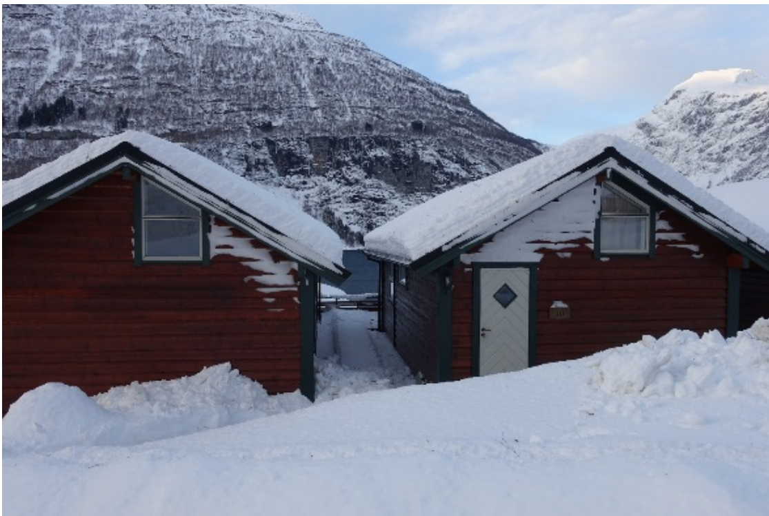
Figur 9 Rotvelt pga skredvind og snø pakket mot hyttevegg
