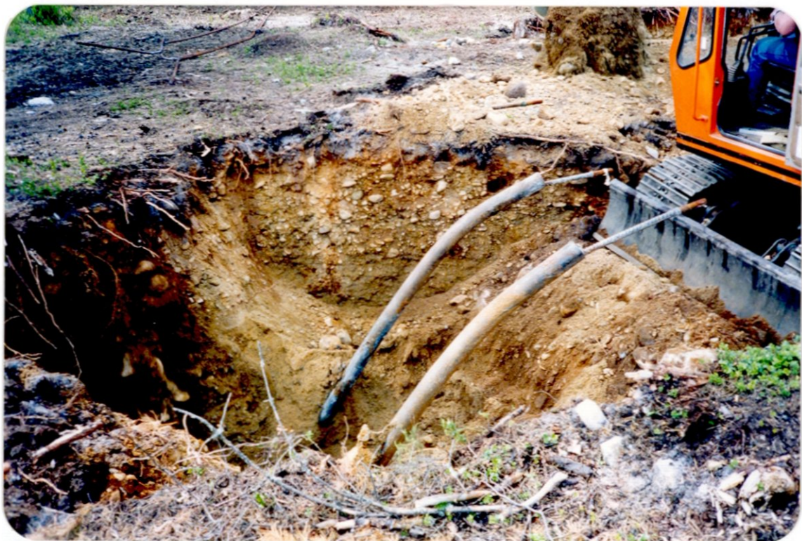
Foto 10 Utbøyning av peler ved radiell belastning
