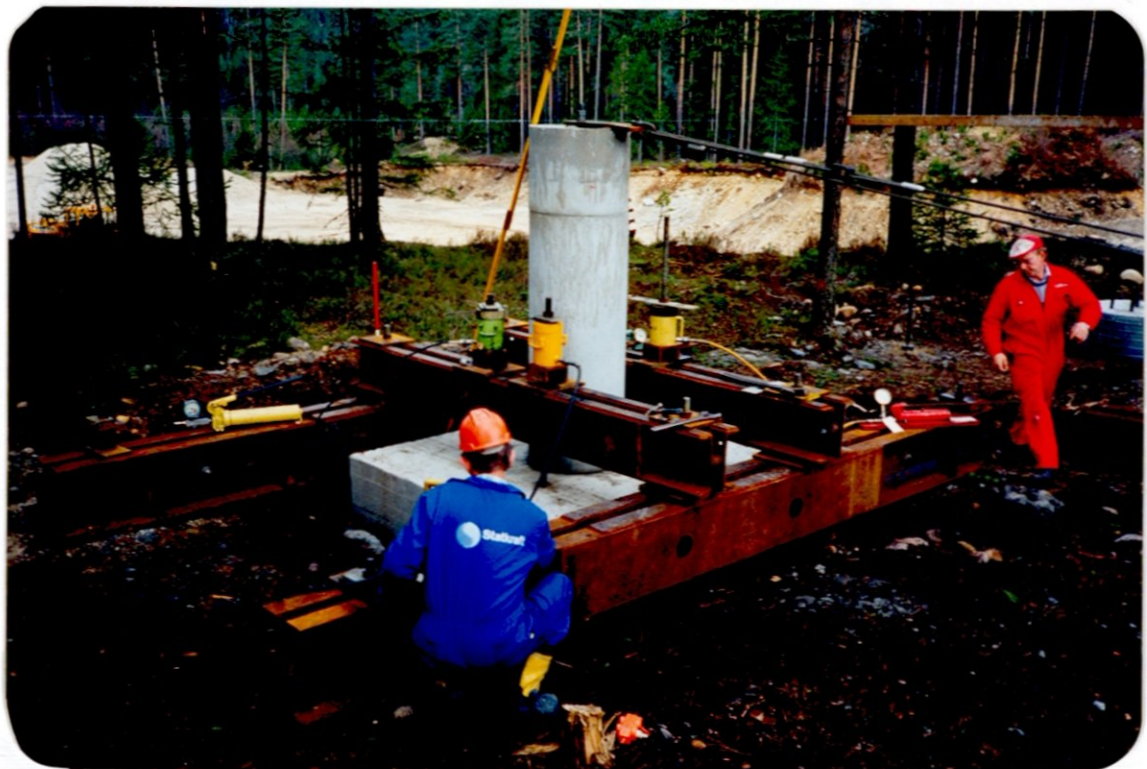
Foto 6 Mastefundament 1 i grus/ sand med ramme for prøvebelastning
