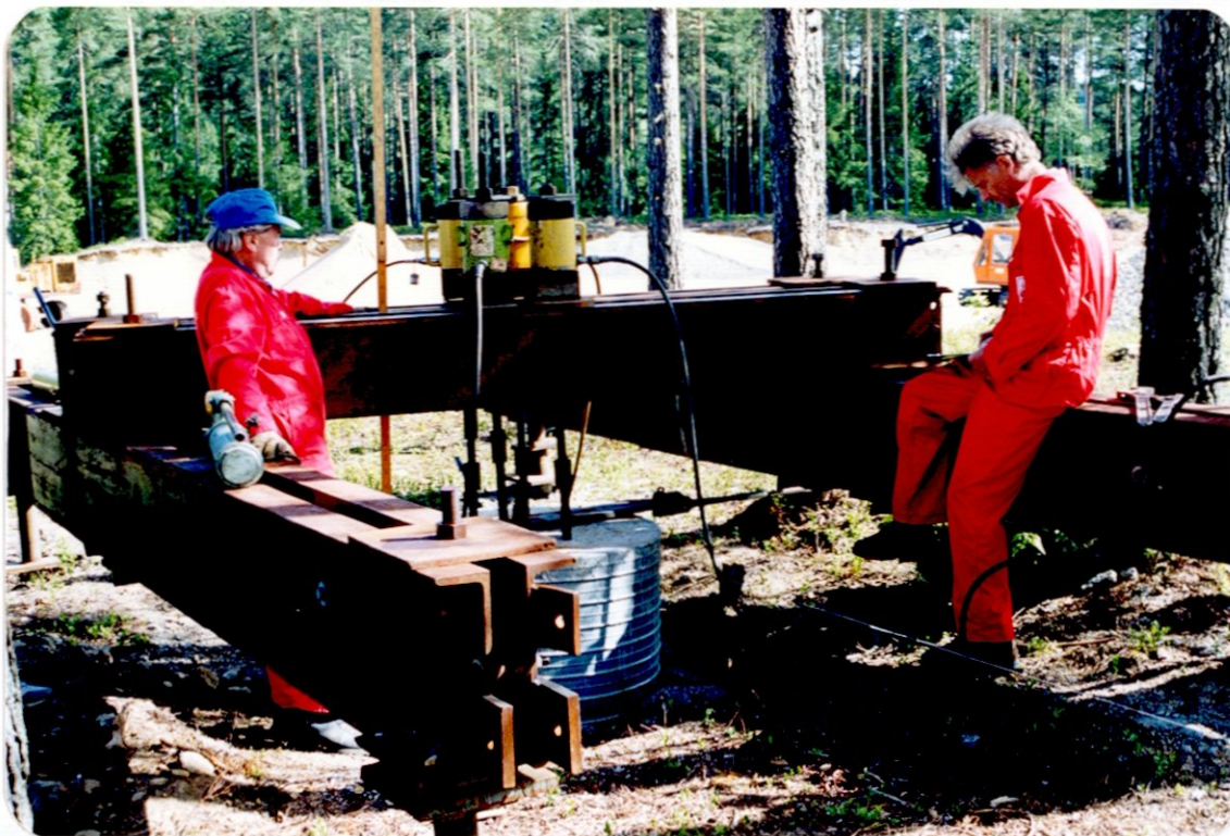
Foto 7 Mastefundament 2 i grus/ sand med ramme for prøvebelastning
