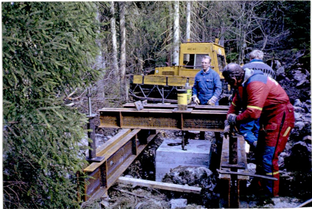
Foto 5 Mastefundament i ur, horisontal grunn, med ramme for prøvebelastning
