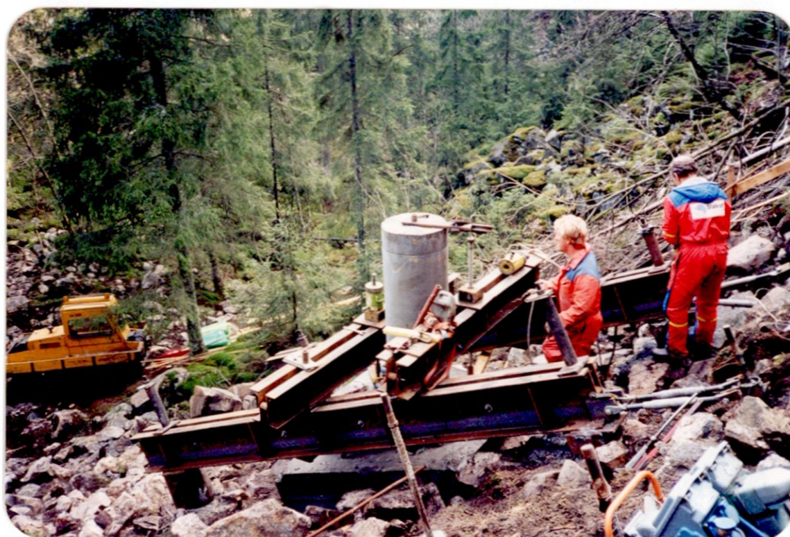
Foto 4 Mastefundament i ur med ramme for prøvebelastning
