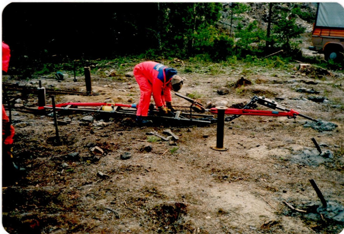
Foto 8 Arrangement for prøvebelastning av skrå peler
