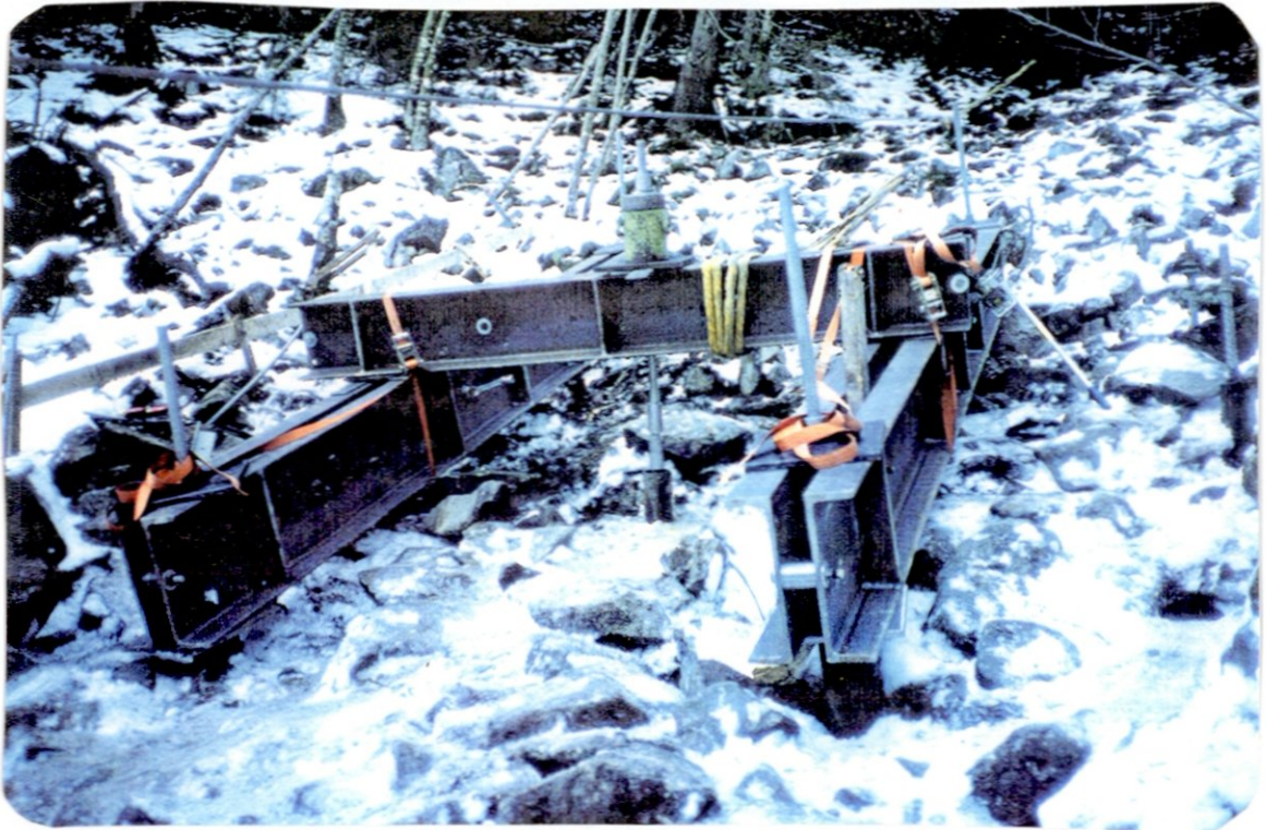
Foto 1 Prøvebelastning av enkeltpel i urskråning, Urdalen
