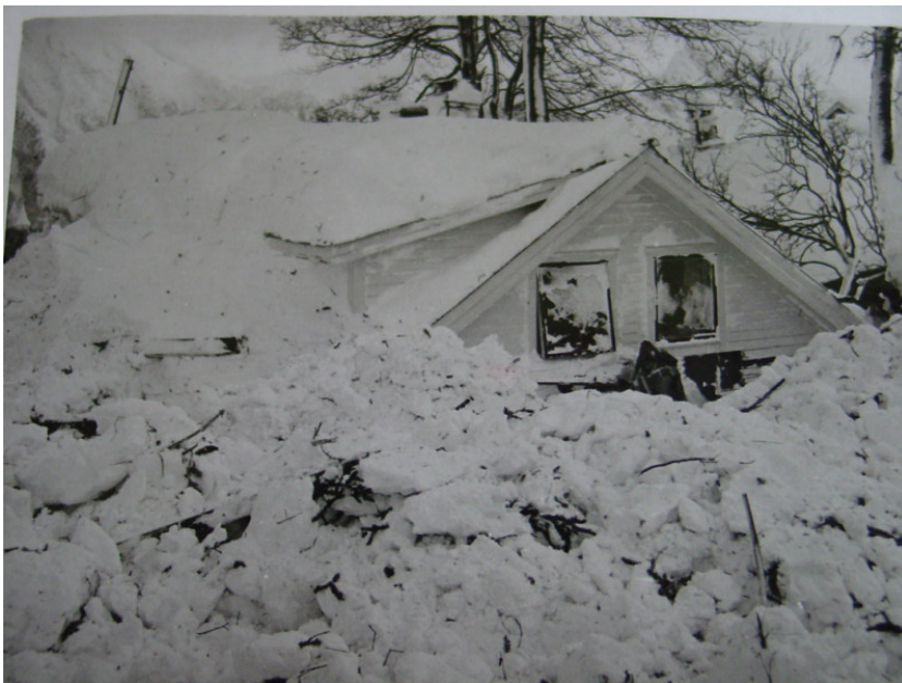
Figur 8-6: Larsastova ble flyttet av grunnmuren og ned på riksvegen; første etasje var knust. Det lå mye skredsnø med stor mektighet nede ved gårdshusa (Foto Anders Hustanes).
