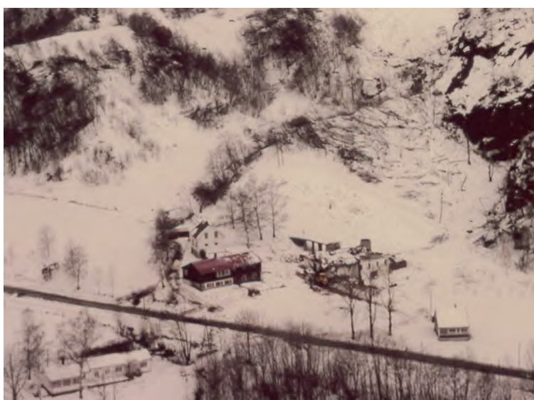
Figur 8-13: Halså gård etter skredhendelsen. Läven var knust, men grunnmuren sto.
